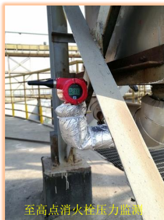
喷淋末端压力监测
