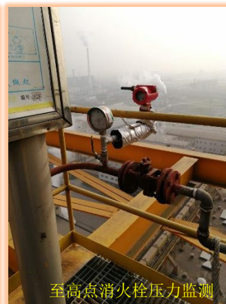
至高点消防栓压力监测
