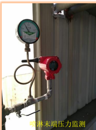
至高点消防栓压力监测
